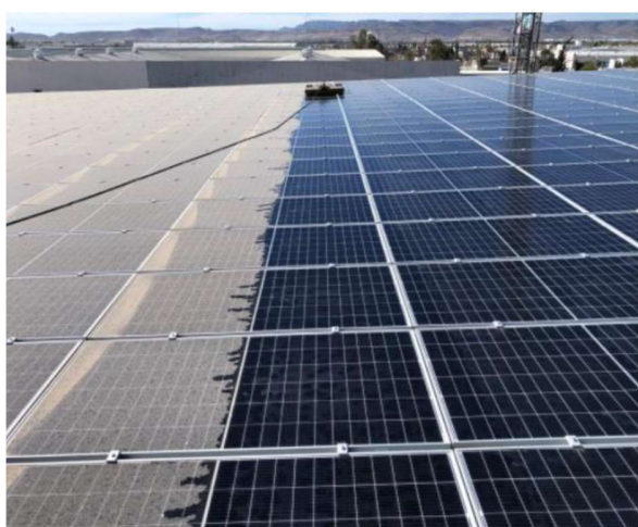
Fig. 11. Limpieza de paneles.
