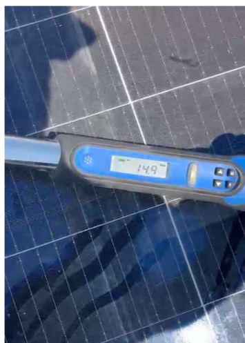
Fig. 10. Prueba de torque en estructura.
