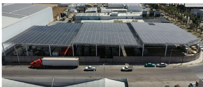
Fig. 6. Suciedad en módulos fotovoltaicos.
