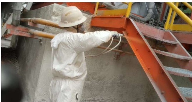
Fig. 1. Pintura de estructuras. Fuente: Elaboración propia.
